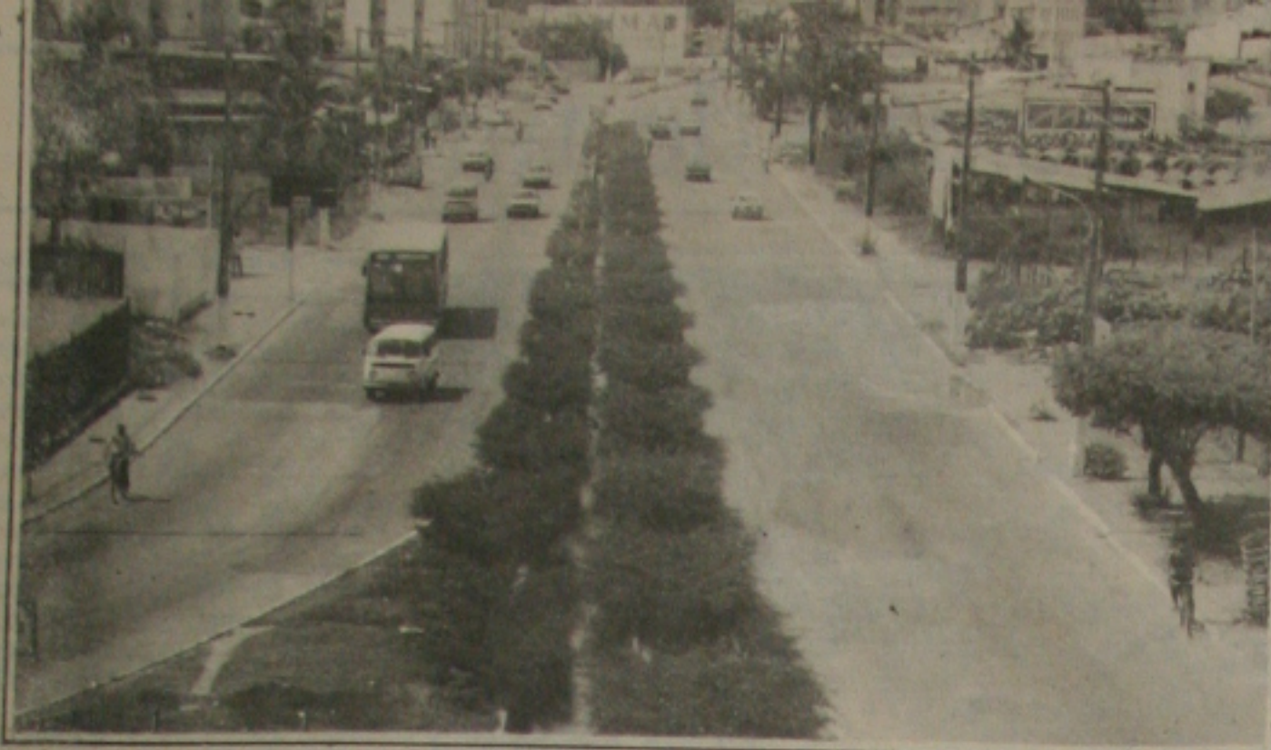
Vista do canal da Hermes Fontes, considerada uma das mais importantes obras da administração do prefeito Wellington Paixão.
