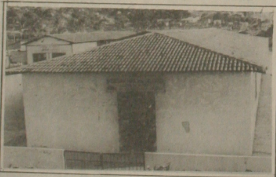
O setor de saúde está sendo prioridade na atual administração. Um exemplo é a construção do Centro de Saúde, Dr. José Augusto Barreto, no Japãozinho.
