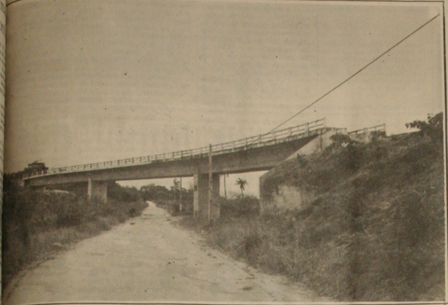
A obra da ponte foram iniciadas em outubro de 89 e até agora não foram concluídas com desperdício do dinheiro público.
