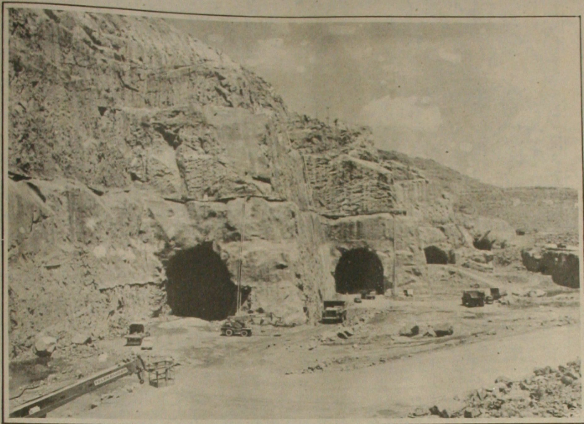
As águas do Rio São Francisco serão desviadas, hoje, por estes quatro túneis
