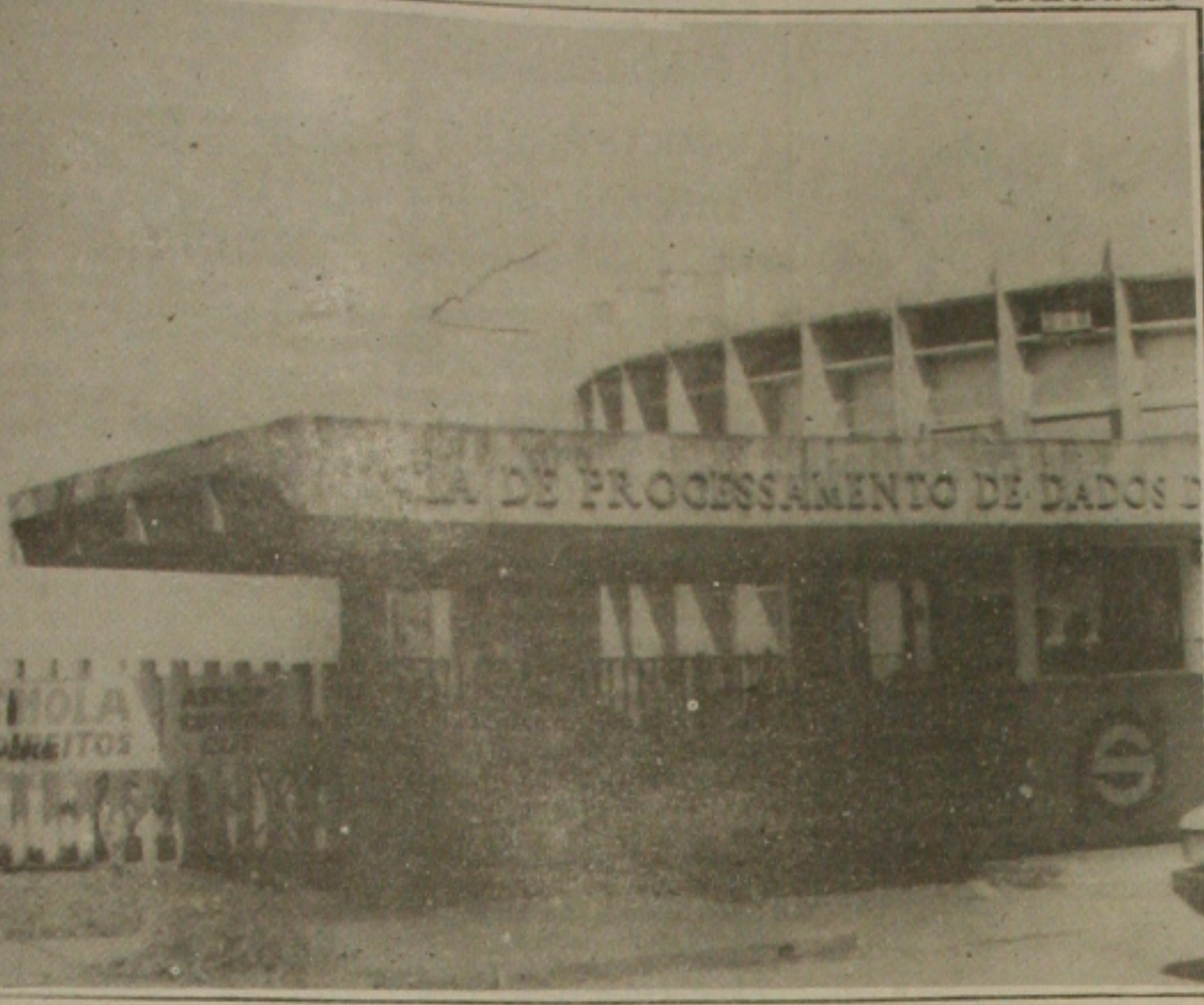
Edifício da Companhia de Processamento de Dados mantém a paralisação e compromete o pagamento de 50 mil servidores do Estado.
