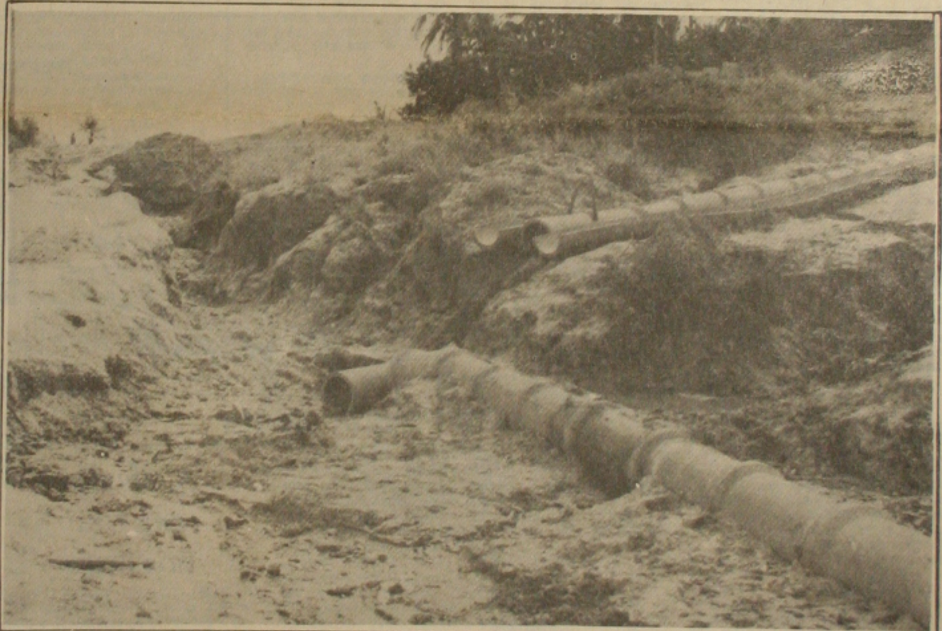
O descaso em São Cristóvão é visível pelo abandono em todos os setores.
