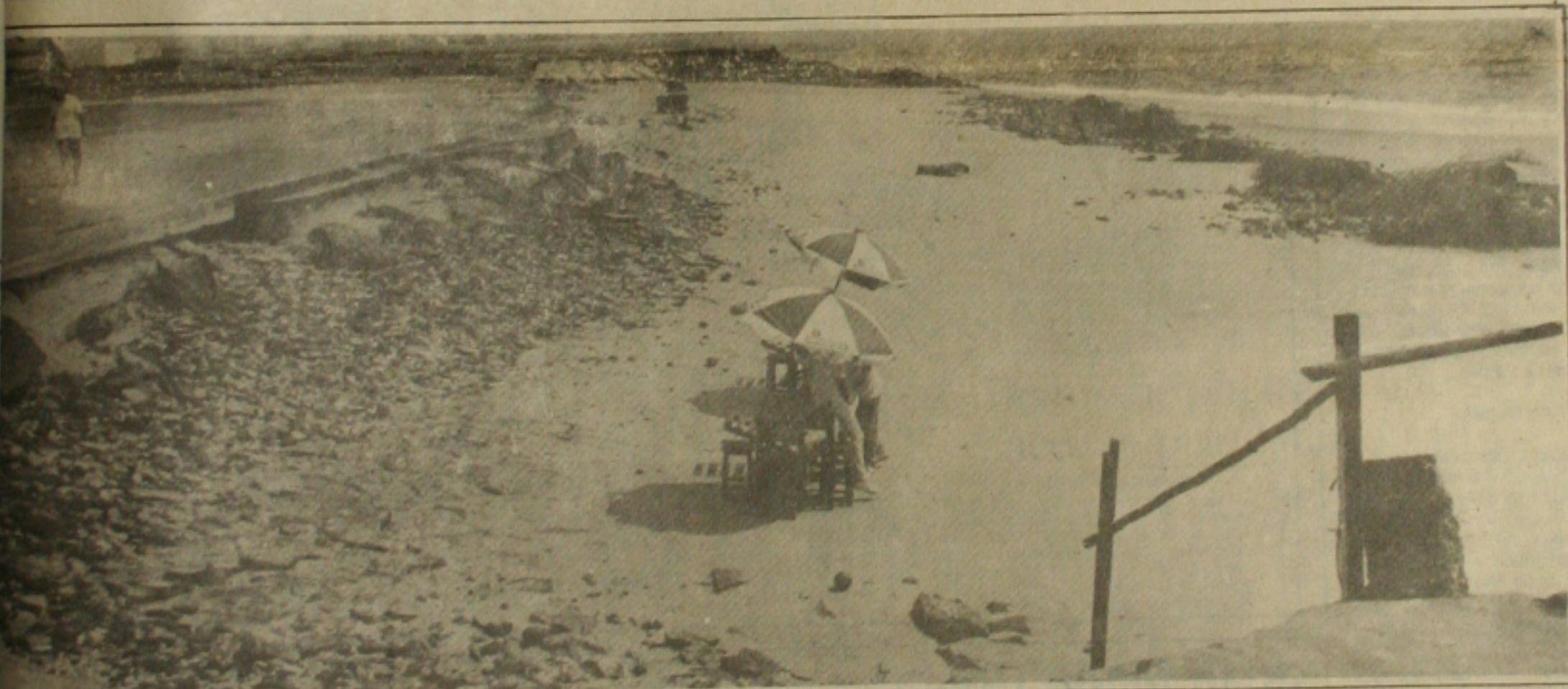
Praia do Meio praticamente destruída pela força do mar, que a cada dia invade mais a praia.
