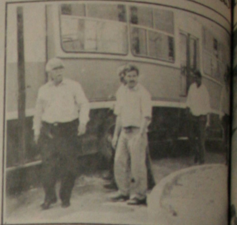
Prefeito inspeciona as obras de ampliação do Terminal Rodoviário de S.S.A.
