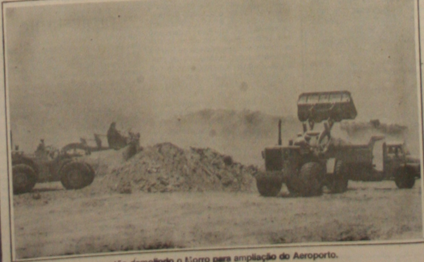
Caminhões e tratores estão demolindo o Morro para ampliação do Aeroporto.
