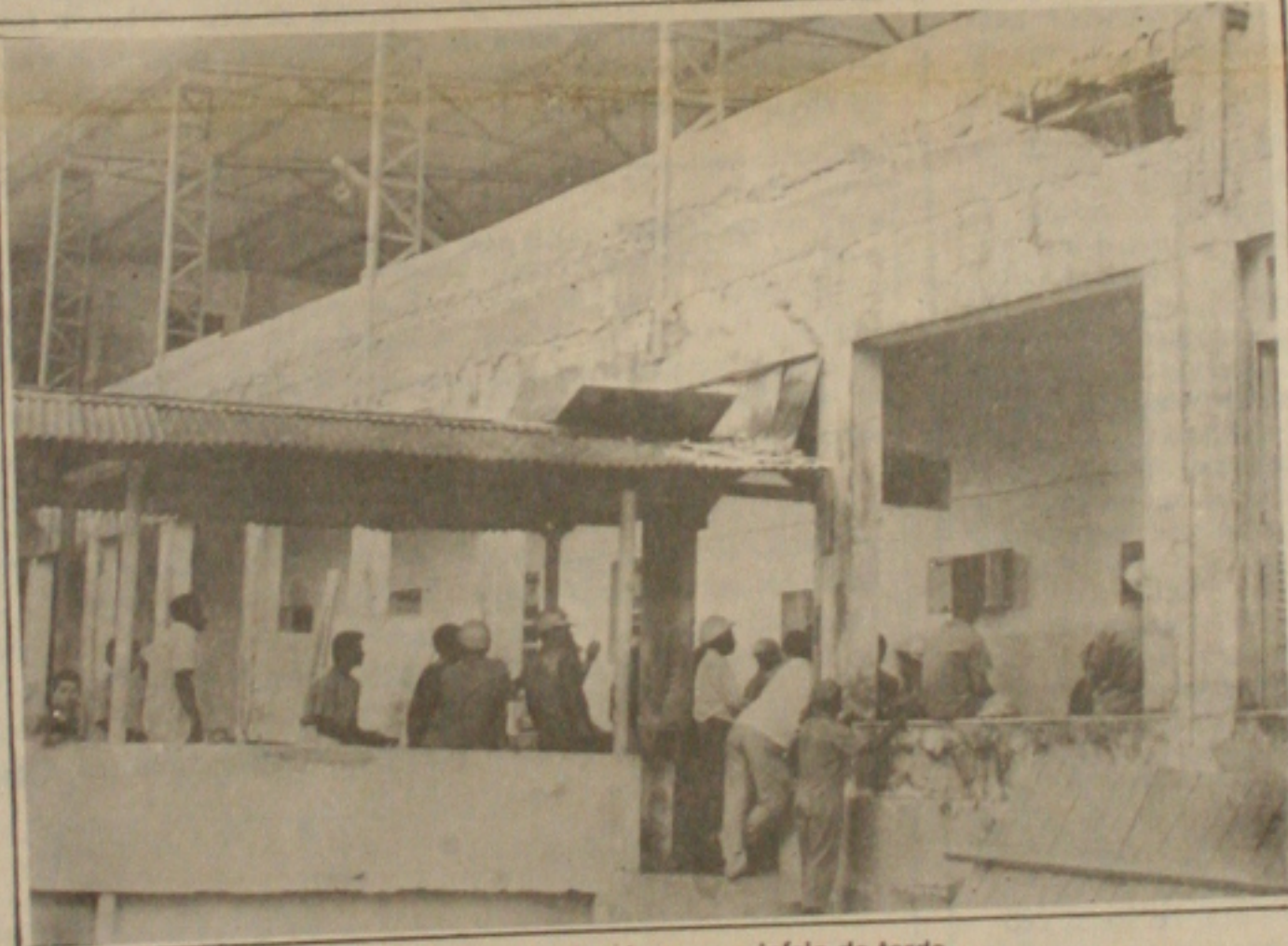
As paredes internas do Centro Cirúrgico desabaram no início da tarde.
