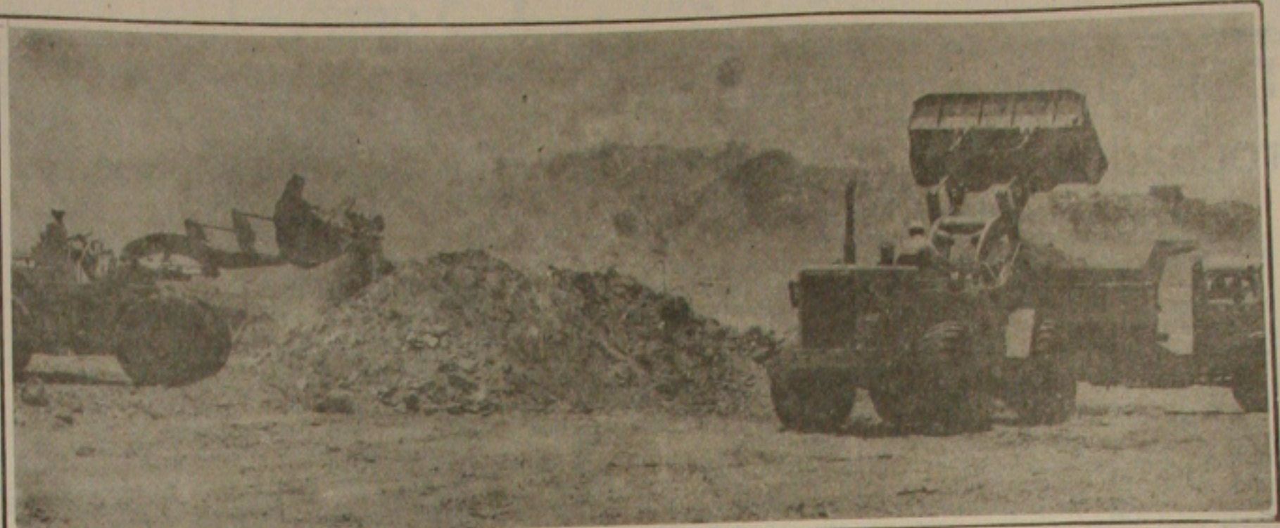
Tratores e escavadeiras da Queiroz Galvão trabalham intensamente...
