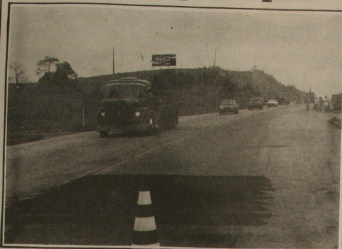
A construção de sonorizadores não resolveu os problemas dos acidentes fatais neste trecho. (Foto: arquivo).
