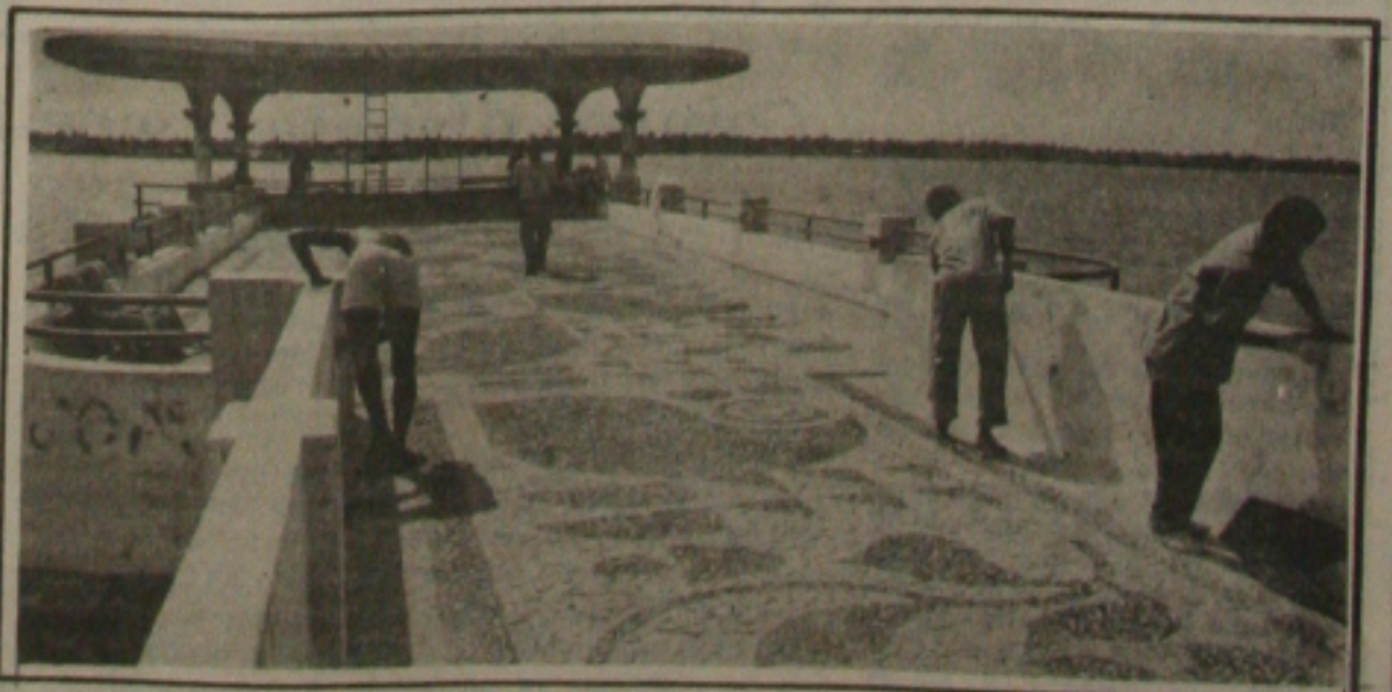
A Ponte do Imperador tornou-se ponto de encontro dos "tombadinhos"
