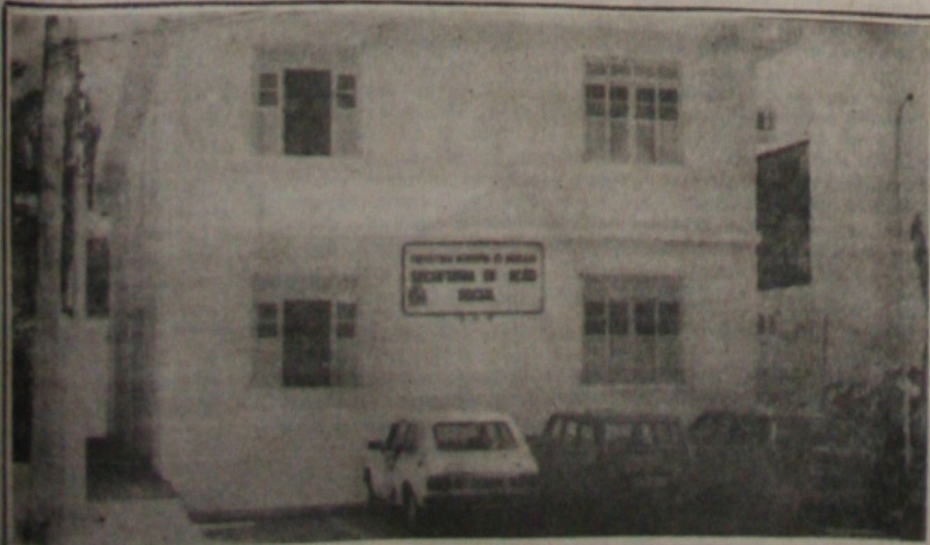
O prédio da Secretaria Municipal está sem água desde ontem
