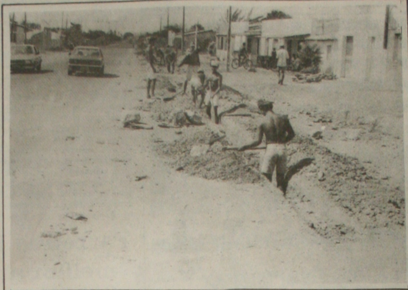
As frentes de trabalho estão suspensas e os trabalhadores não receberam salários.
