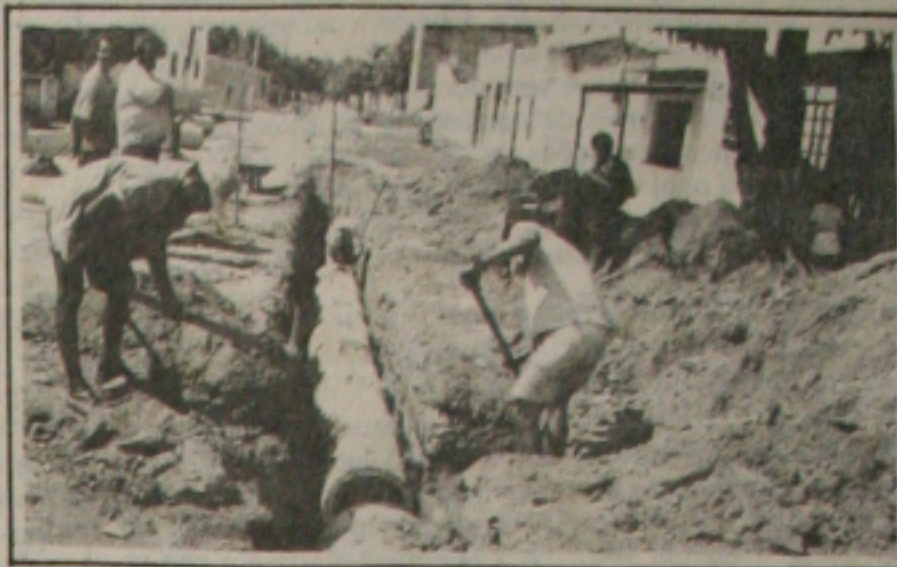
Depois da drenagem, a rua Corretor Otoniel será pavimentada
