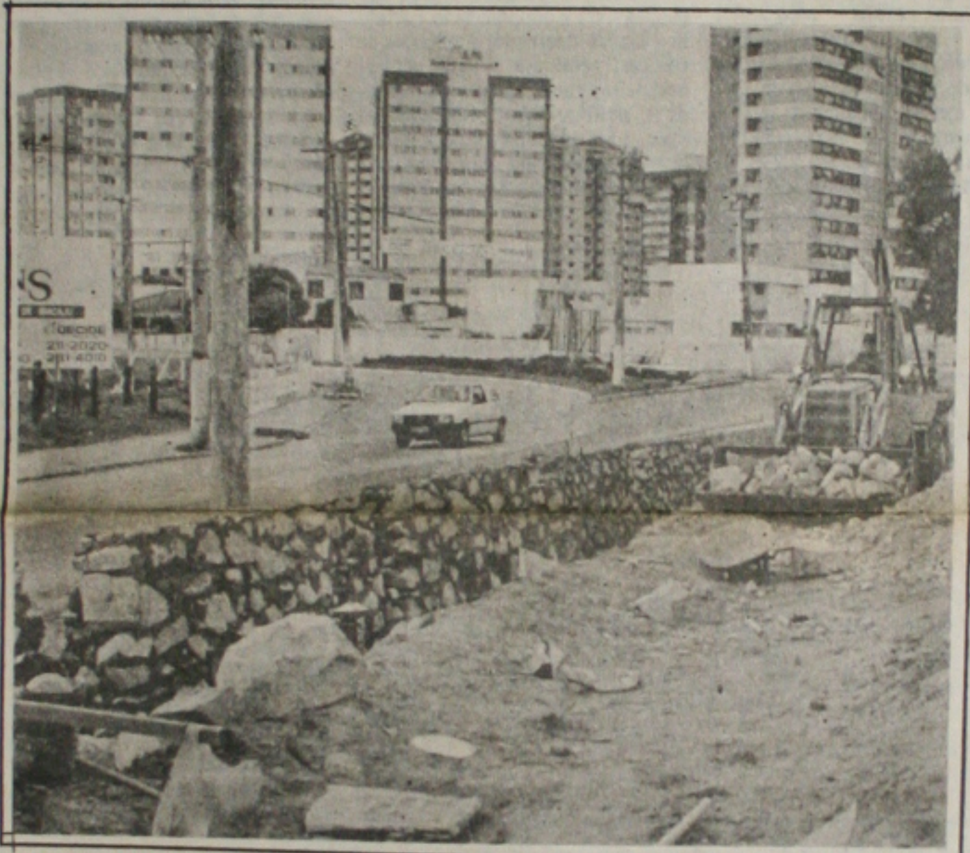
As obras na Beira Mar estão bastante adiantadas e devem ser concluídas em breve
