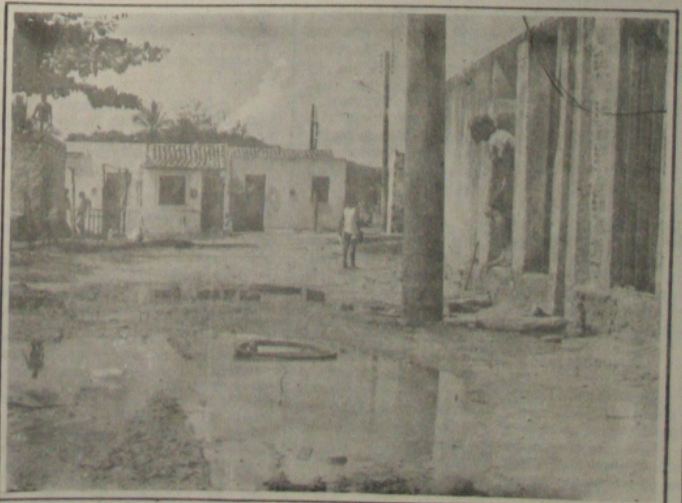
Na rua Puraza Bonfim, a tão prometida pavimentação ainda não chegou.
