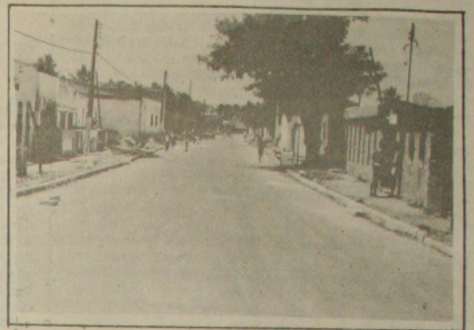
A rua Corretor Otoniel recebeu serviços de drenagem, terraplenagem e pavimentação.
