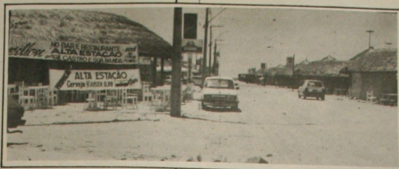
A falta de pavimentação na área dos bares é uma das reclamações dos comerciais
