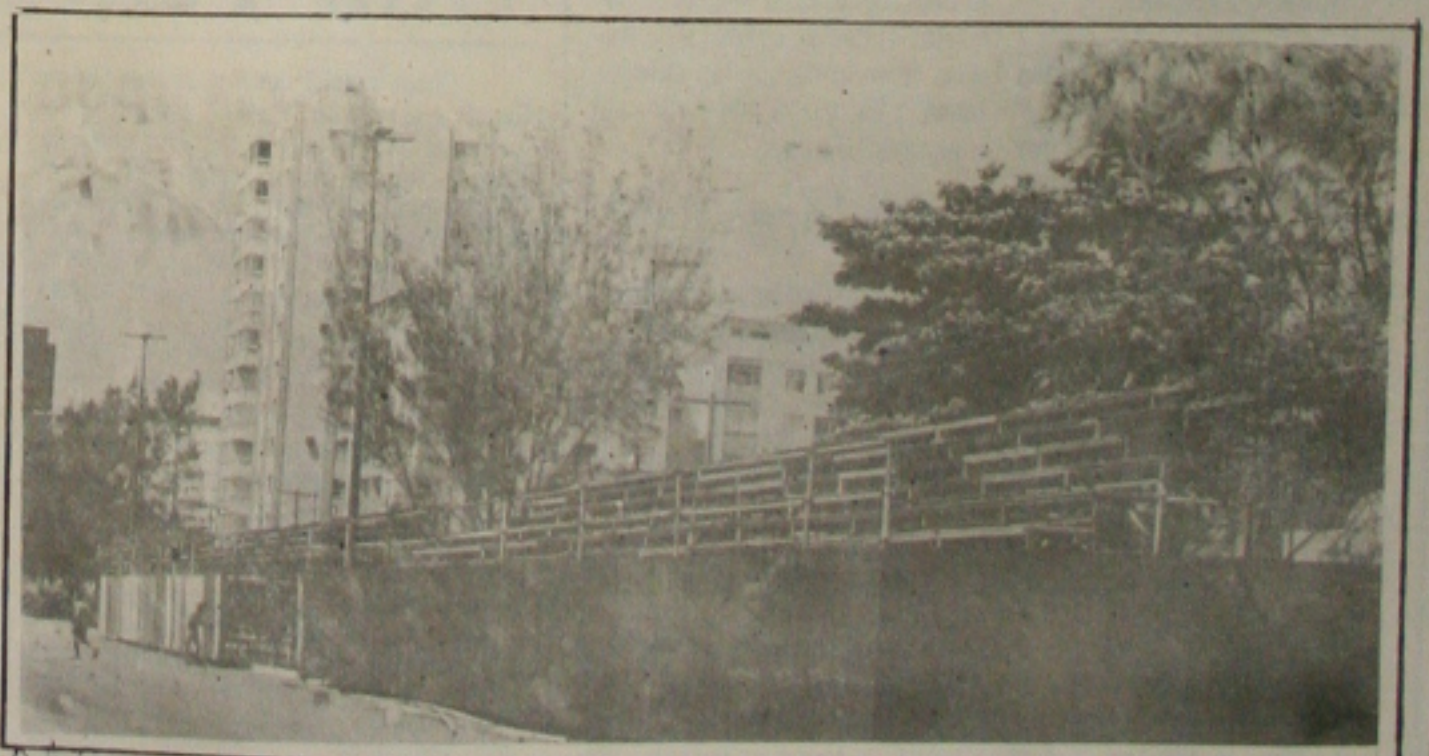
As arquibancadas do Pré-Caju estão sendo implantadas sobre os canteiros da avenida Beira Mar.
