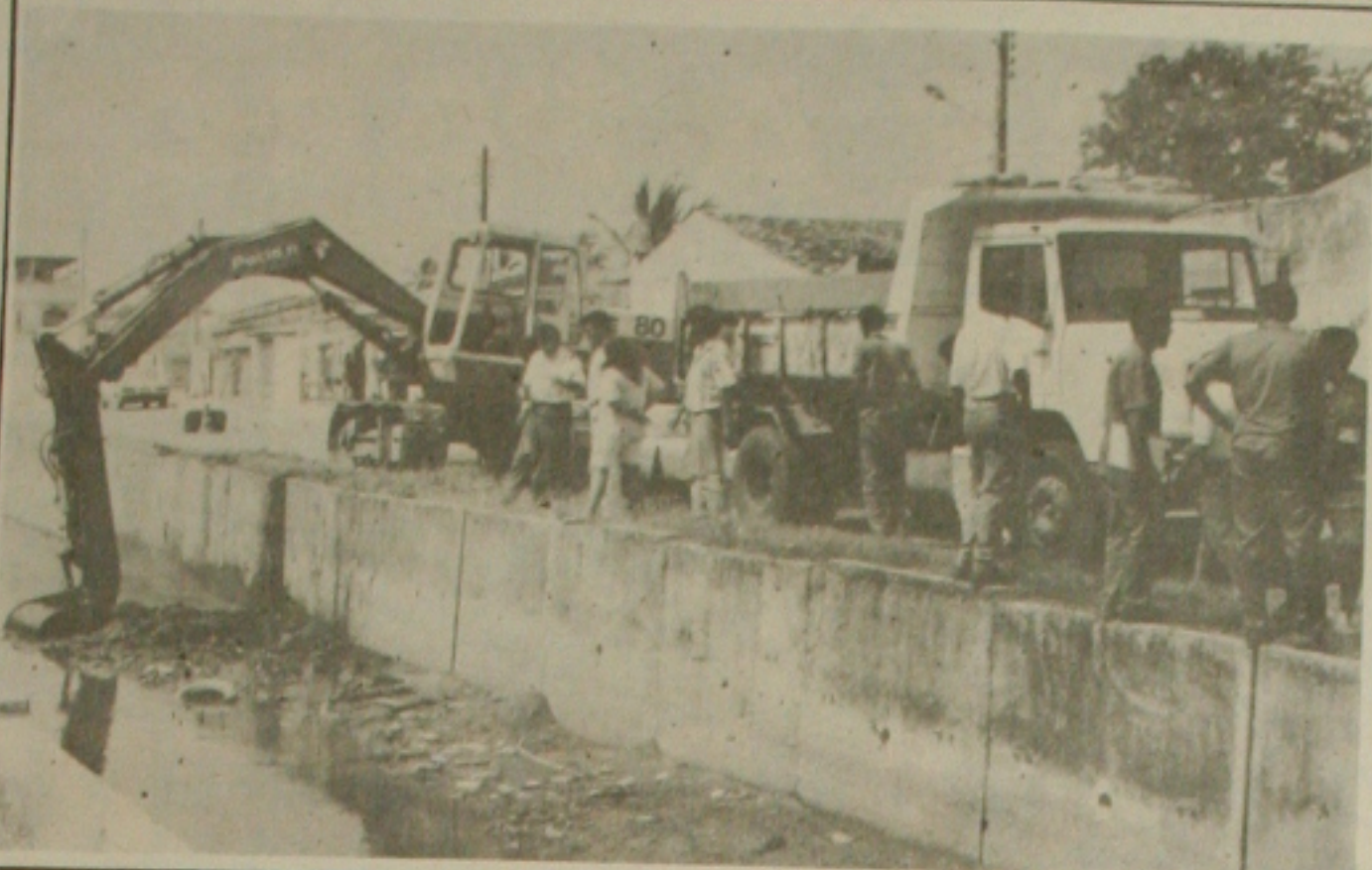
O prefeito Almeida Lima acompanha o início dos trabalhos de limpeza no Industrial.
