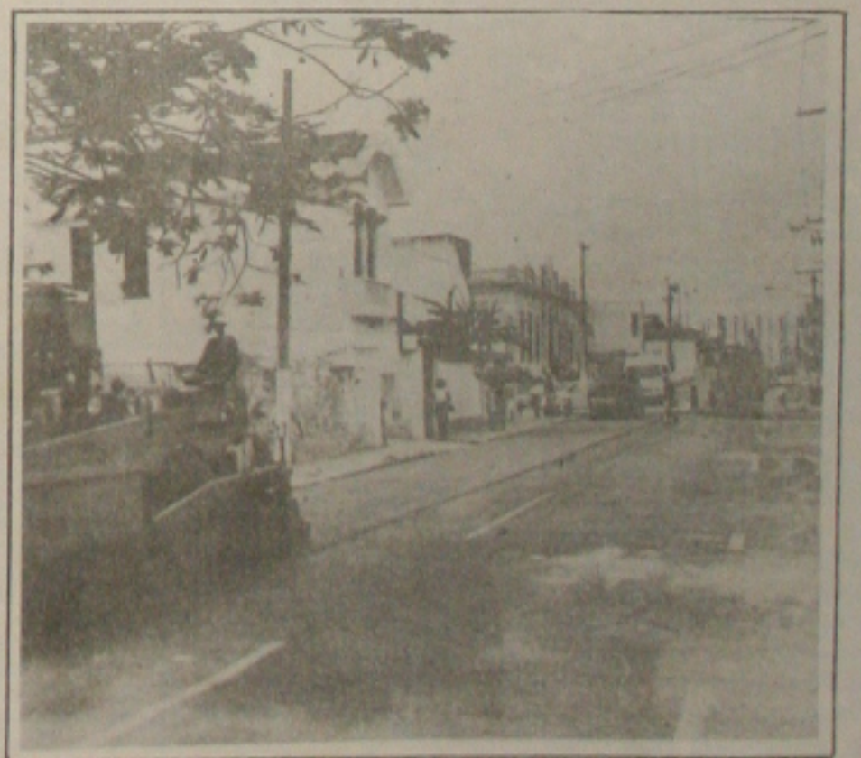
Dez mil metros quadrados de asfalto já foram consumidos no recapeamento
