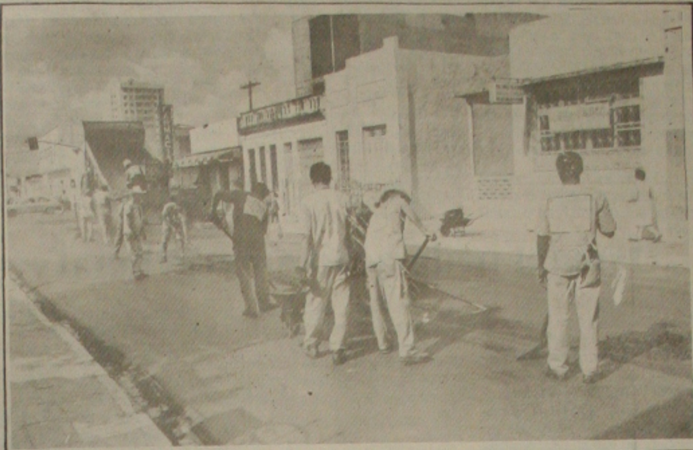
A PMA conclui o recapeamento de mais uma rua no centro comercial de Aracaju (Foto: Abmael Eduardo)
