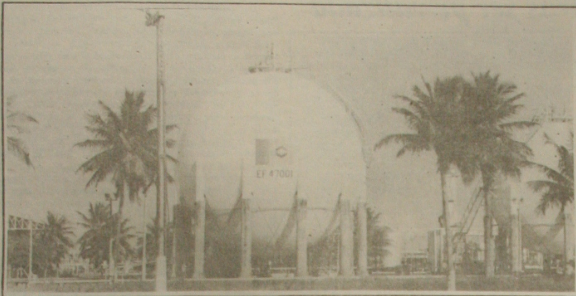
Os estoques de gás de cozinha no Tecarmo asseguram o abastecimento nos Estados de Sergipe e Alagoas.
