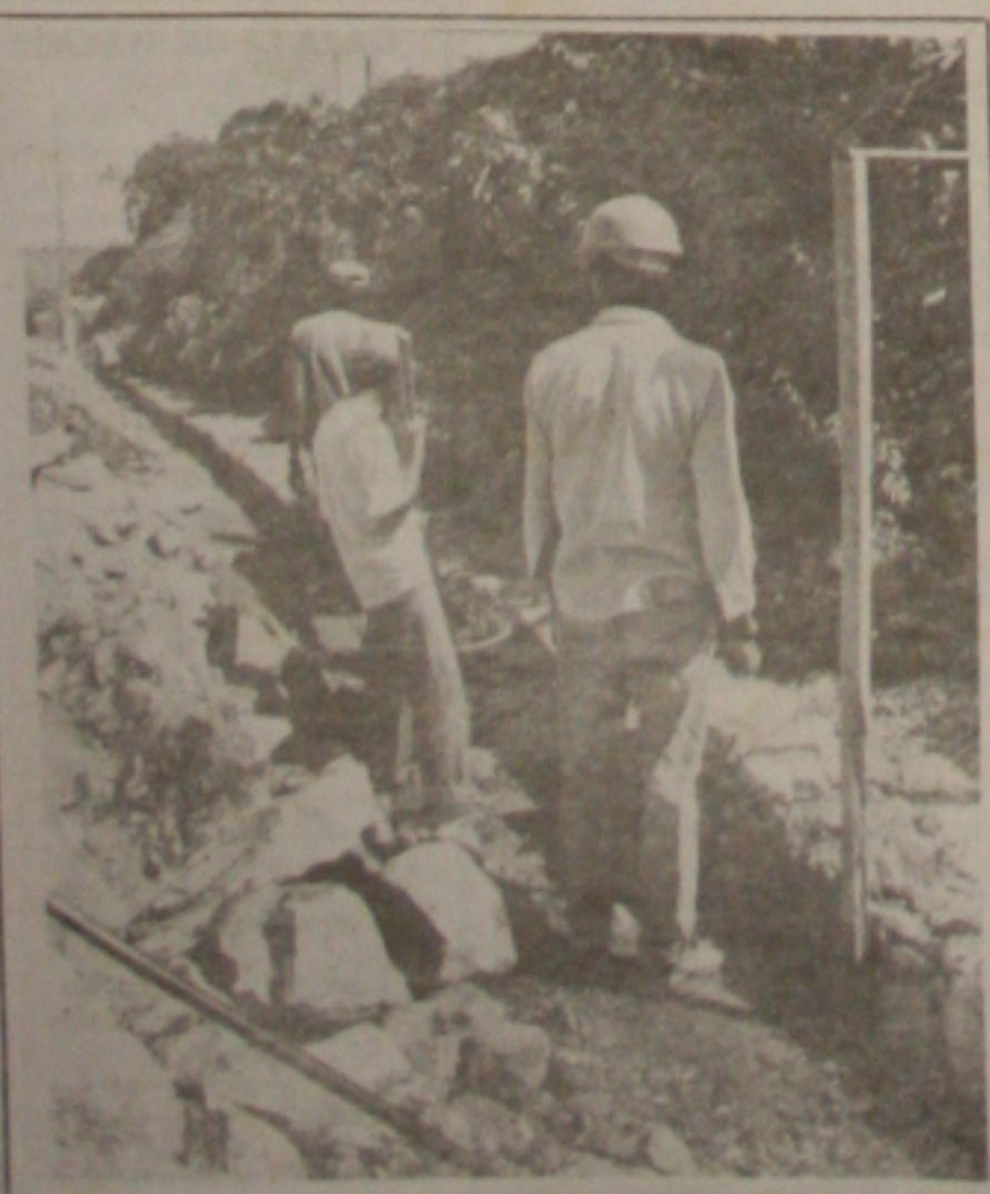
Com a construção do muro de contenção, a prefeitura espera evitar que a população corra riscos de acidentes graves
