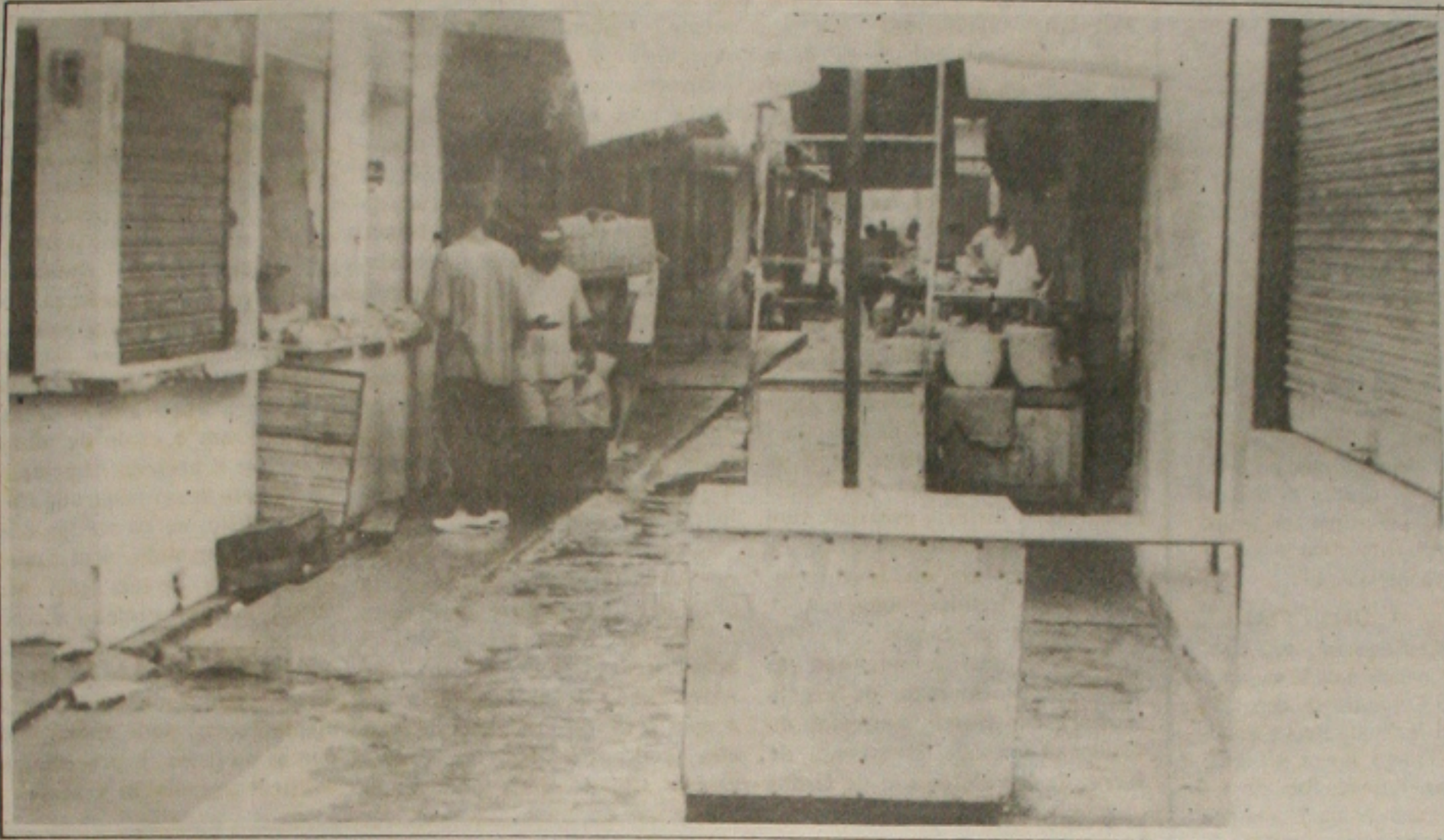
Abandonado pelo poder público, o mercado público hoje se constitui num amontoado de ruelas
