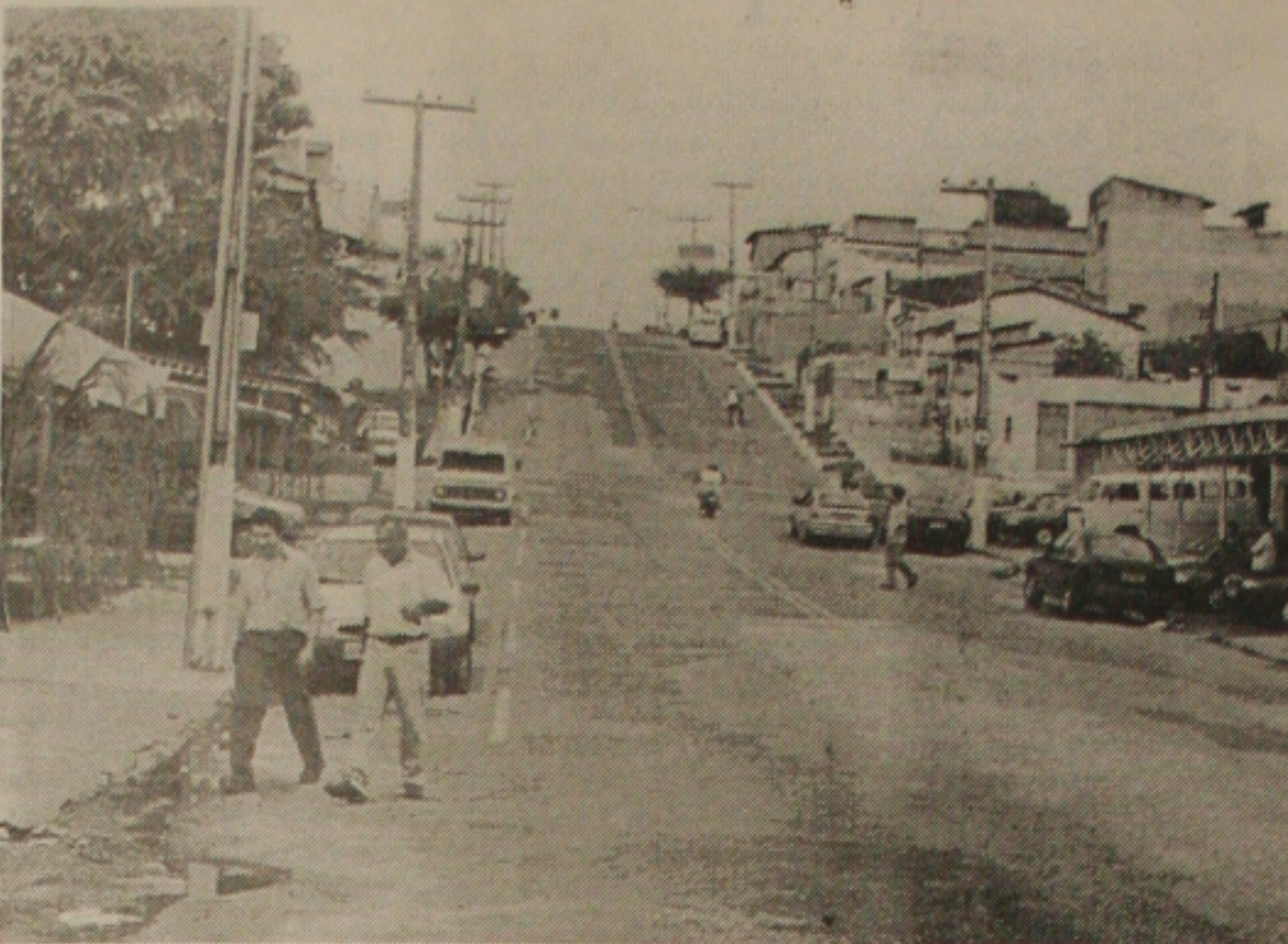
O trânsito nesse local será interditado hoje para a construção do viaduto e do primeiro túnel da capital
