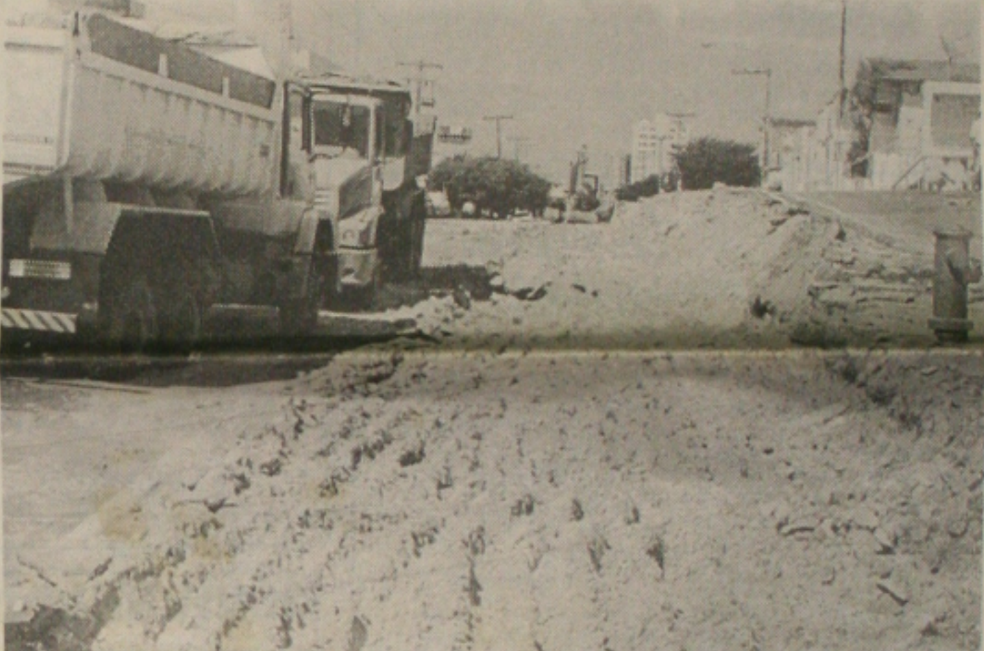
Homens e máquinas da Emsurb iniciaram ontem as obras do novo elevado, na avenida Pedro Calazans.
