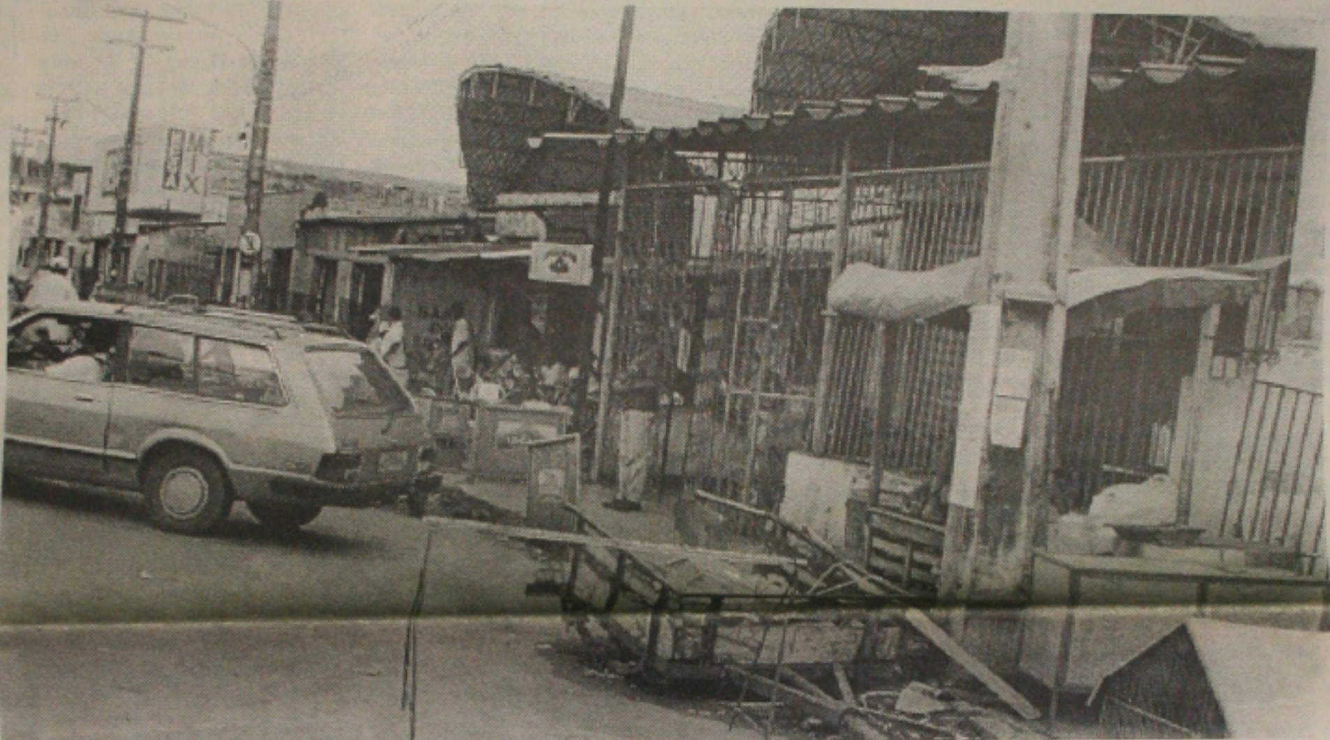
A retirada dos barraqueiros que comercializam até animais é necessária para a conclusão das obras do mercado
