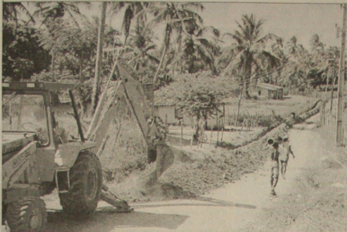
Pacatuba se transformou nos últimos 12 meses num canteiro de obras
