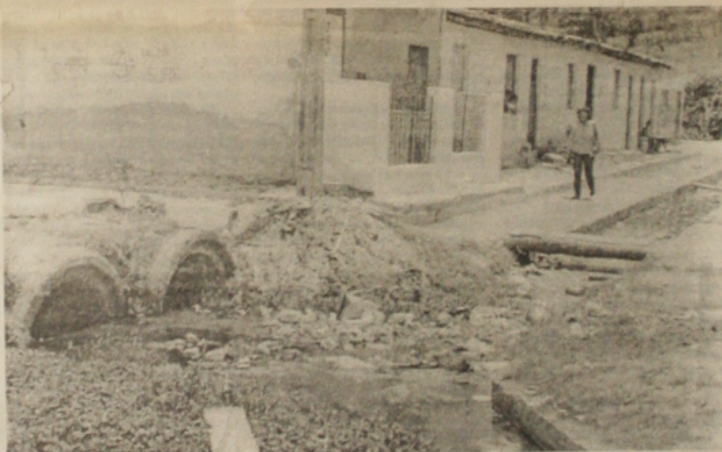
Lixo acumulado nos esgotos tem sido a principal causa para o surgimento da leptospirose
