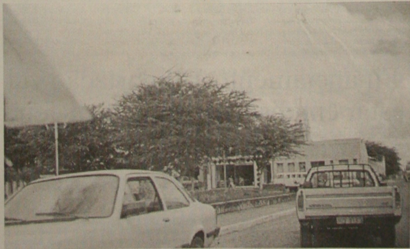
A cidade de Frei Paulo será beneficiada ainda este ano com a construção de 152 casas pela Cehop
