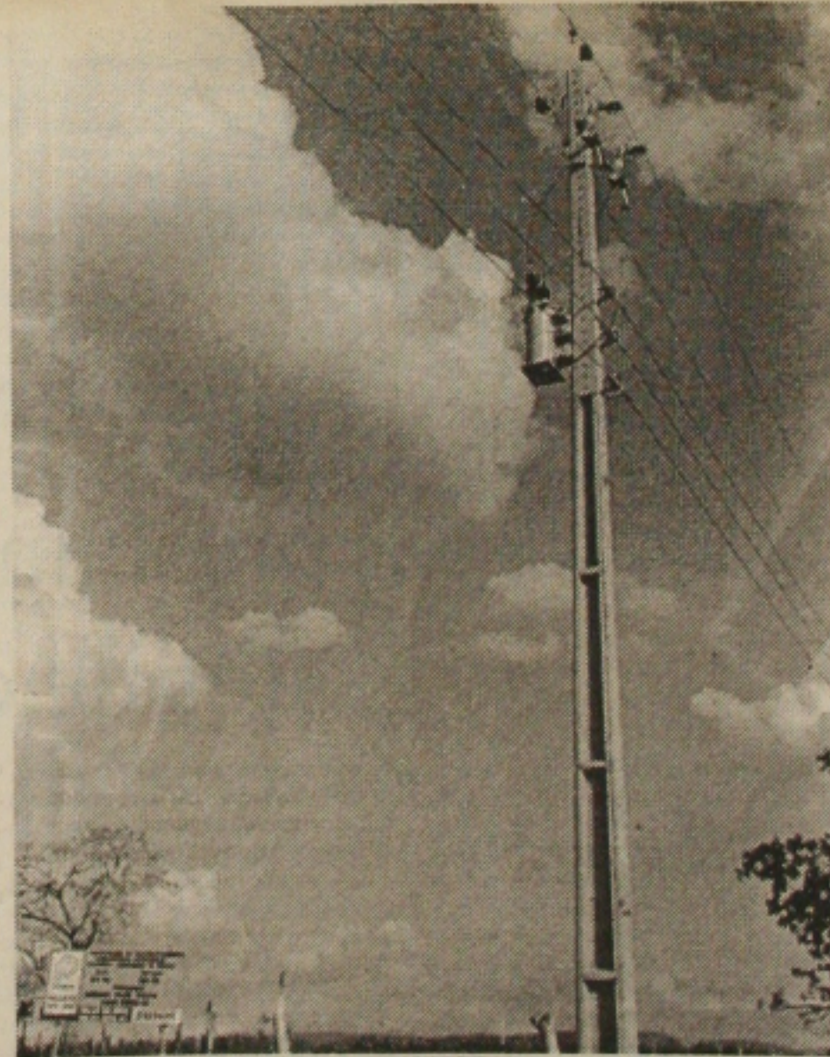
Eletrificação rural chega a localidades de Poço Verde
