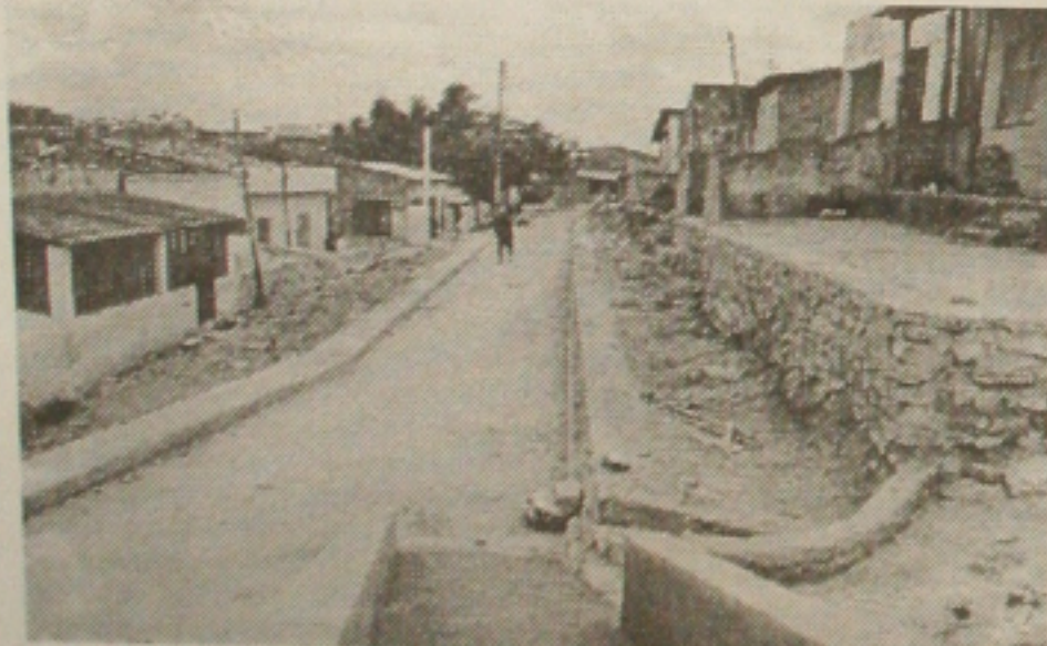
Jardim Centenário beneficiado com obras
