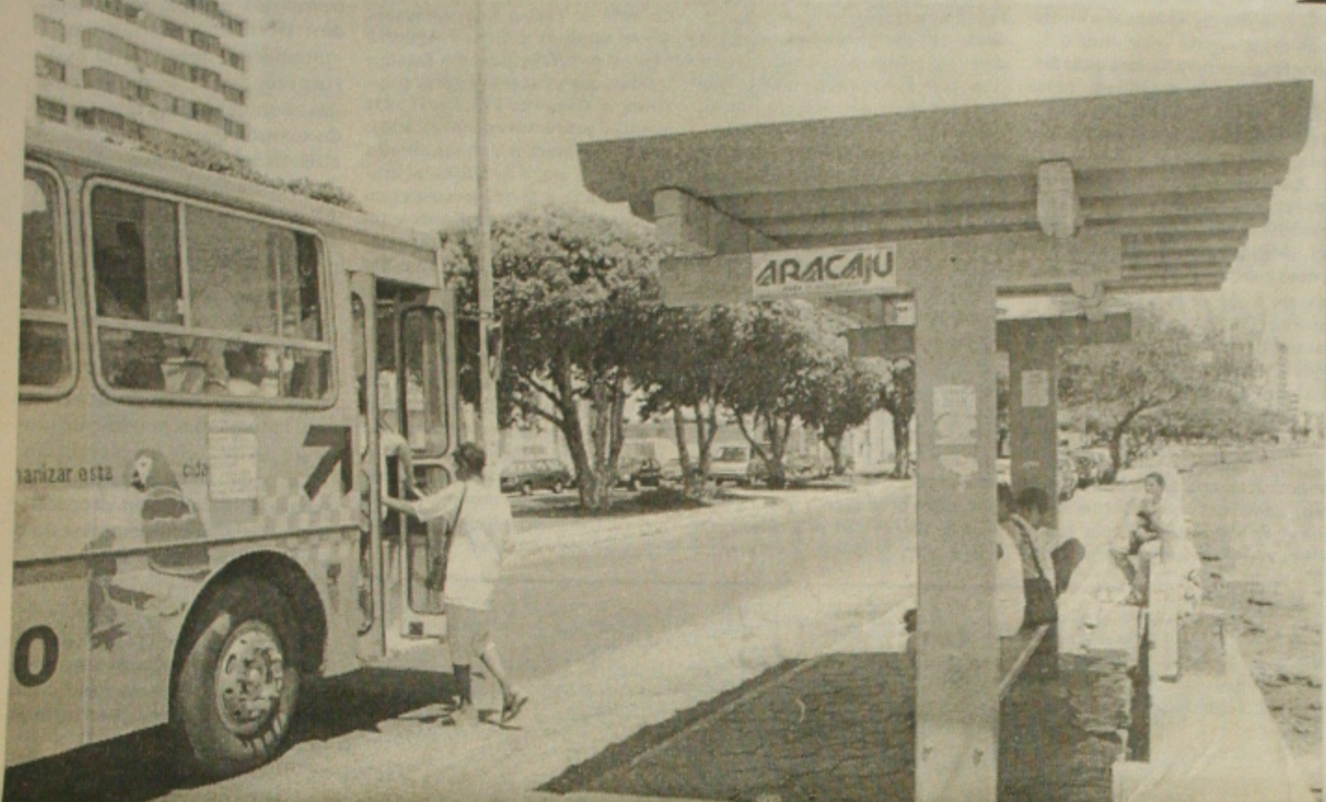
A destruição de abrigos de ônibus em Aracaju vem causando prejuízos mensais à PMA de cerca de R$ 30 mil. (Página 6A)
