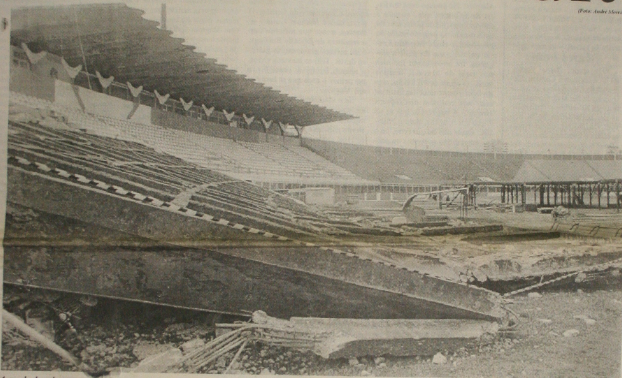
A queda da cobertura, toda de concreto, destruiu cerca de 700 cadeiras no lado da torcida do Confiança, causando a interdição do estádio
