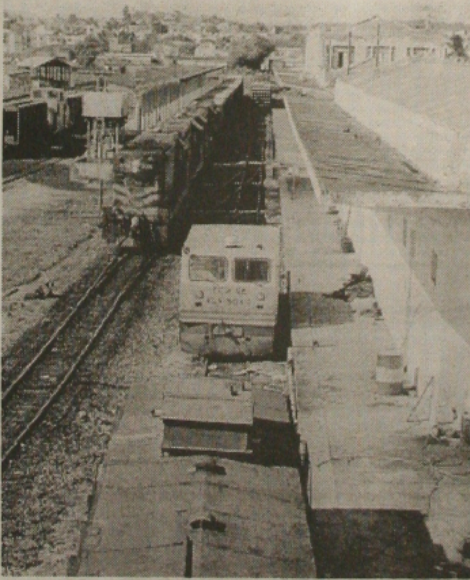
Segundo o Sindiferro, a falta de manutenção transformou a malha ferroviária em Sergipe em ferrovia de alto risco. (Página 5A)
