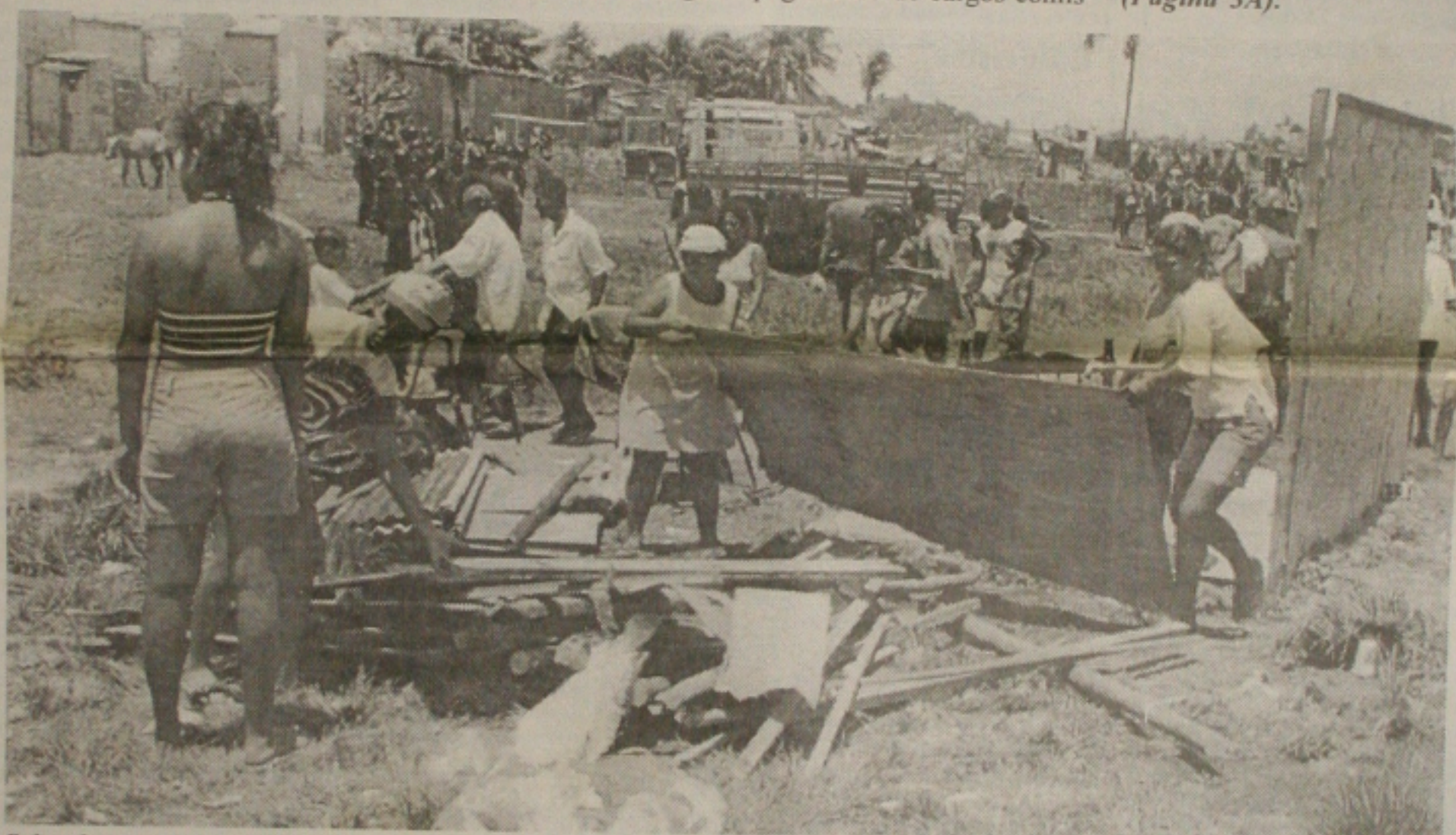
Sob a observação do pelotão de choque da Polícia Militar, as famílias retiravam o que sobrou depois da demolição dos barracos no Lamarão
