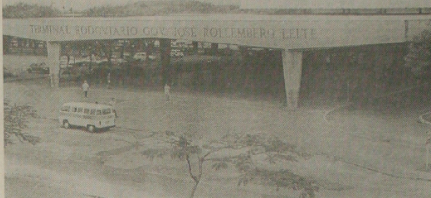
Terminal ficou mais abandonado com a terceirização
