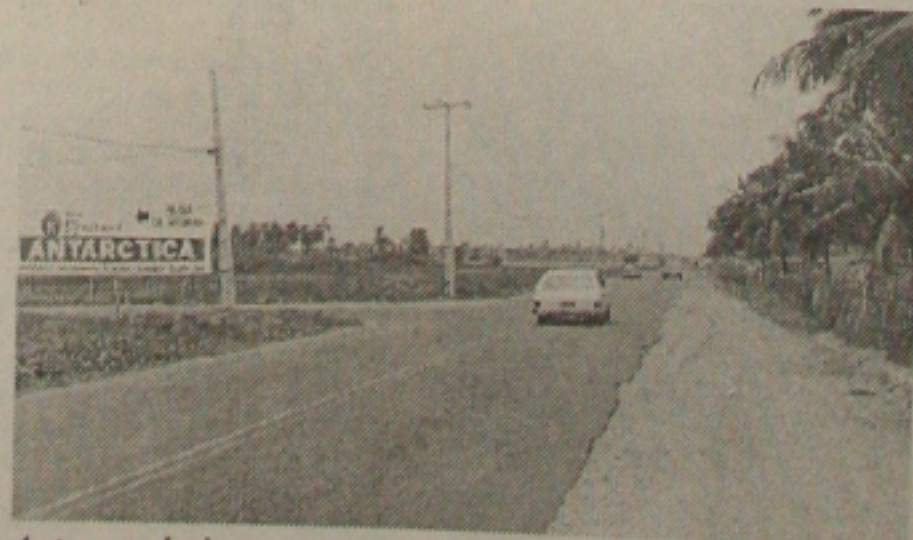
Antes a rodovia representava perigo por falta de manutenção
