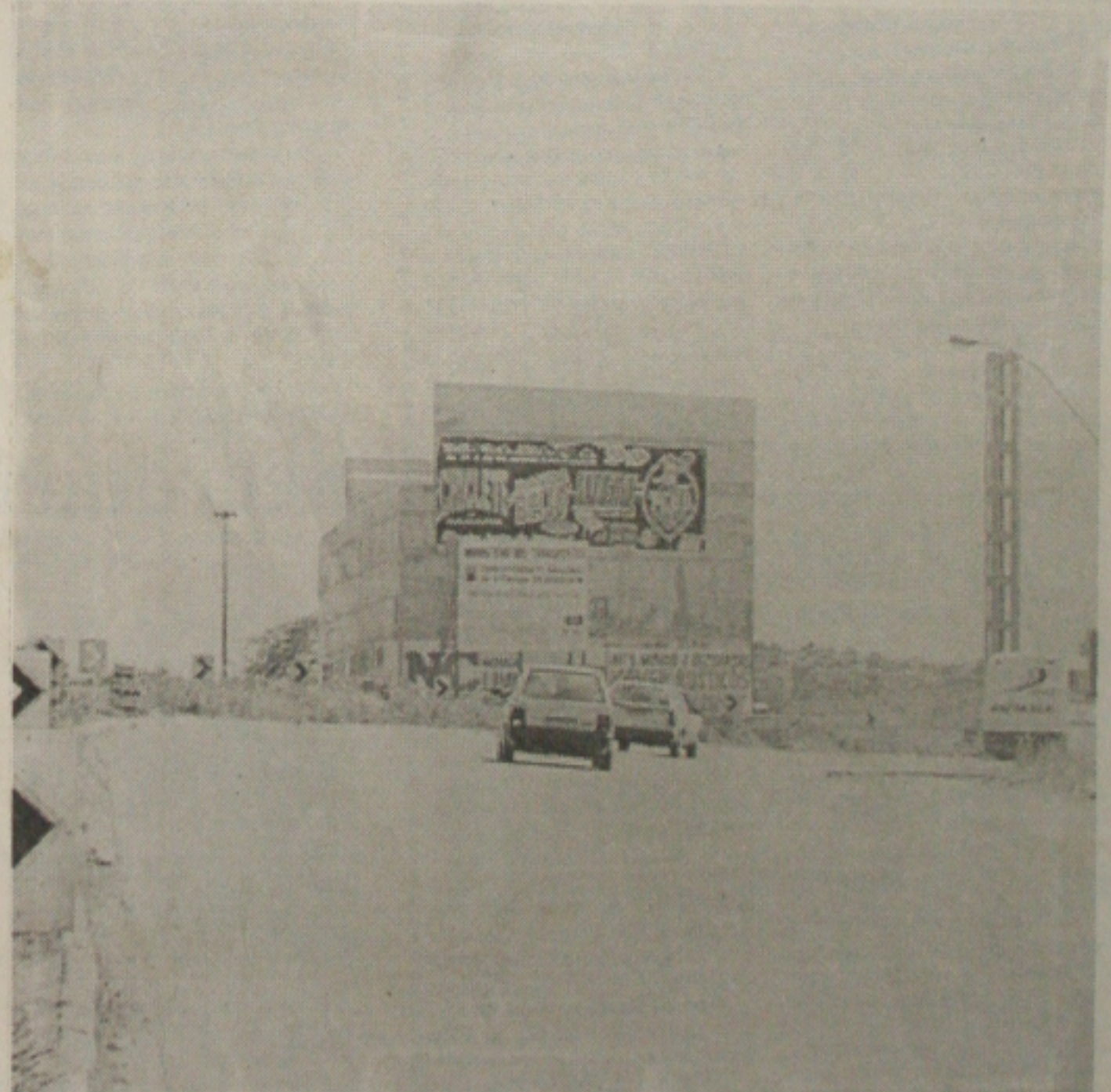
Paralisadas, por falta de verbas, as obras correm o risco de se transformar em "elefantes brancos"
