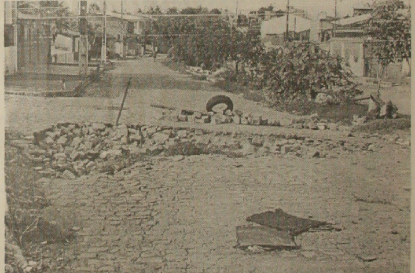
No bairro Cidade Nova a calçada ficou completamente danificada
