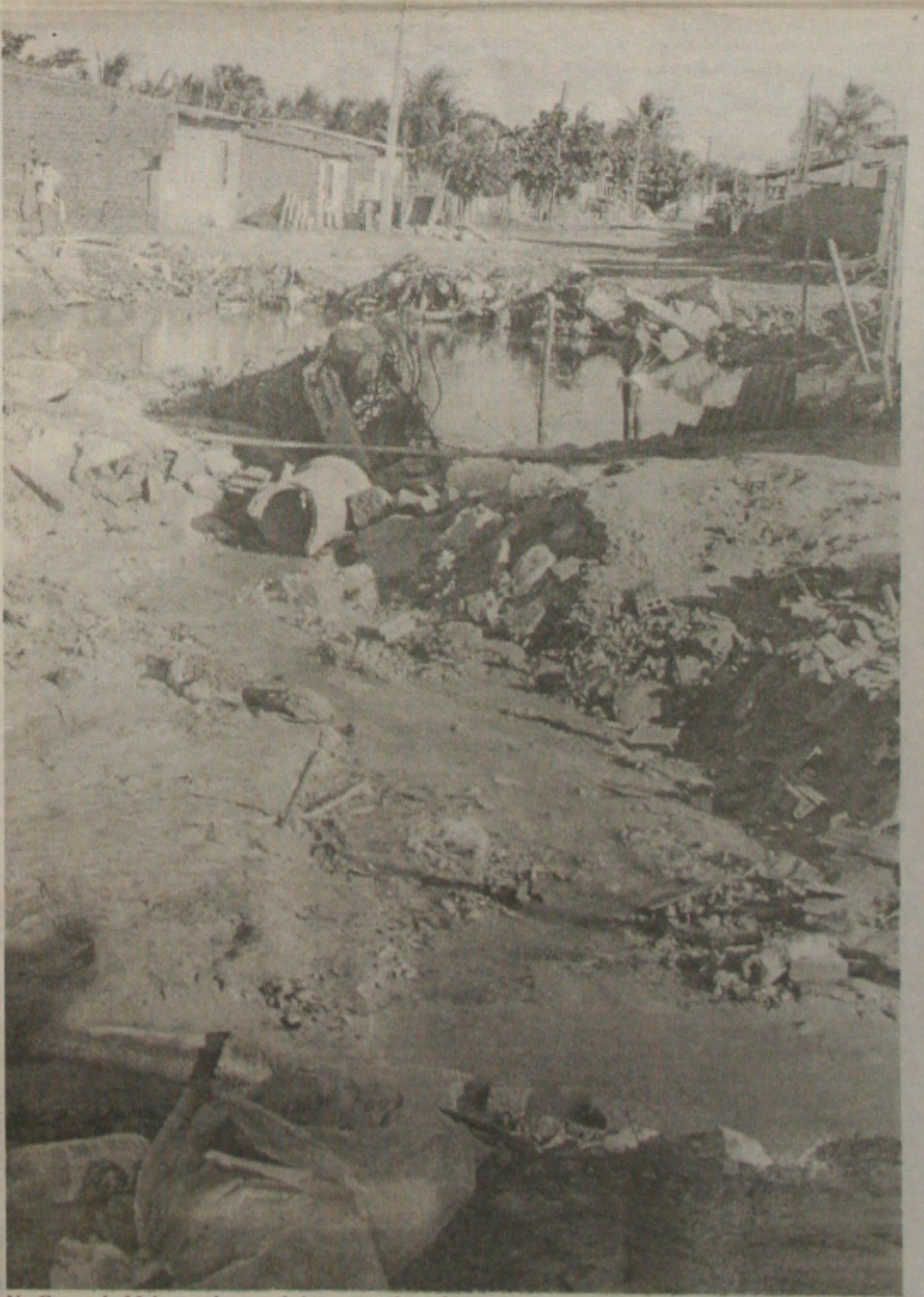
Na Coroa do Meio, as chuvas abriram grandes valas nas ruas sem saneamento e pavimentação
