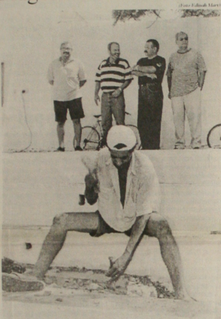
Operários dão os retoques no estádio Sabino Ribeiro, sob os olhares dos dirigentes da Confiança
