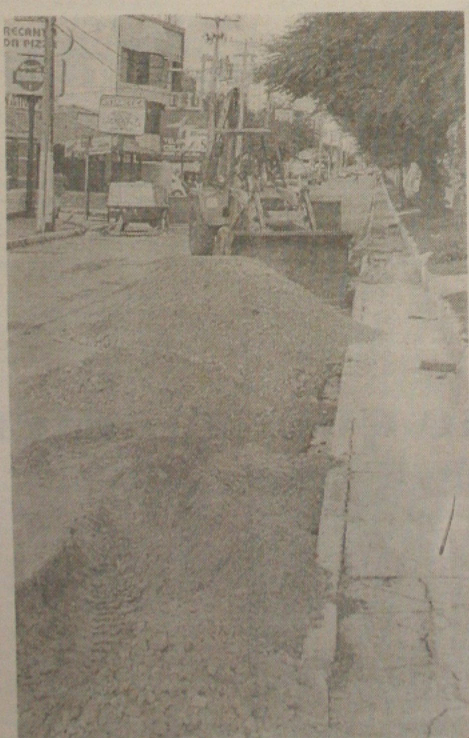
Na Francisco Porto, as obras executadas pelo Deso geram transtornos
