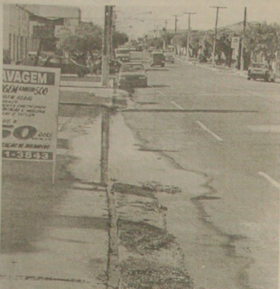
O mau cheiro de esgoto infere moradores da Pedro Calazans
