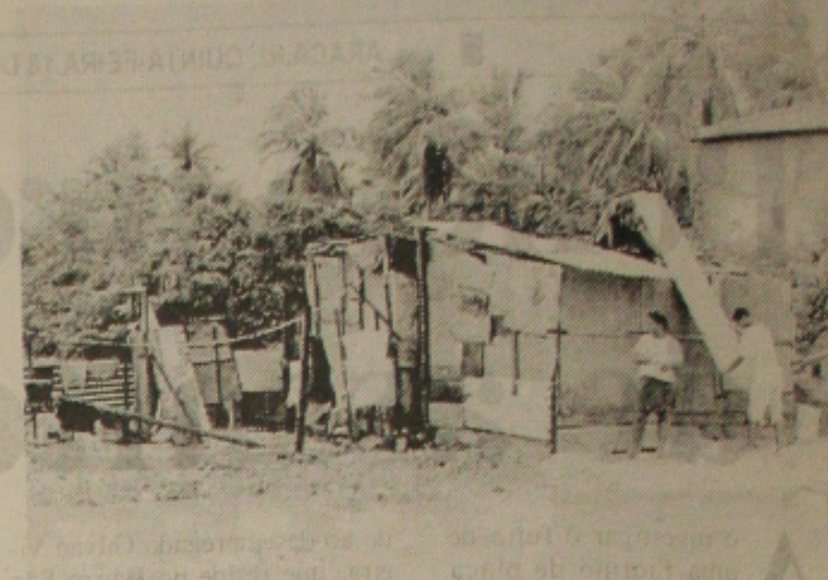
Moradores tentam reconstruir barracos que desabaram
