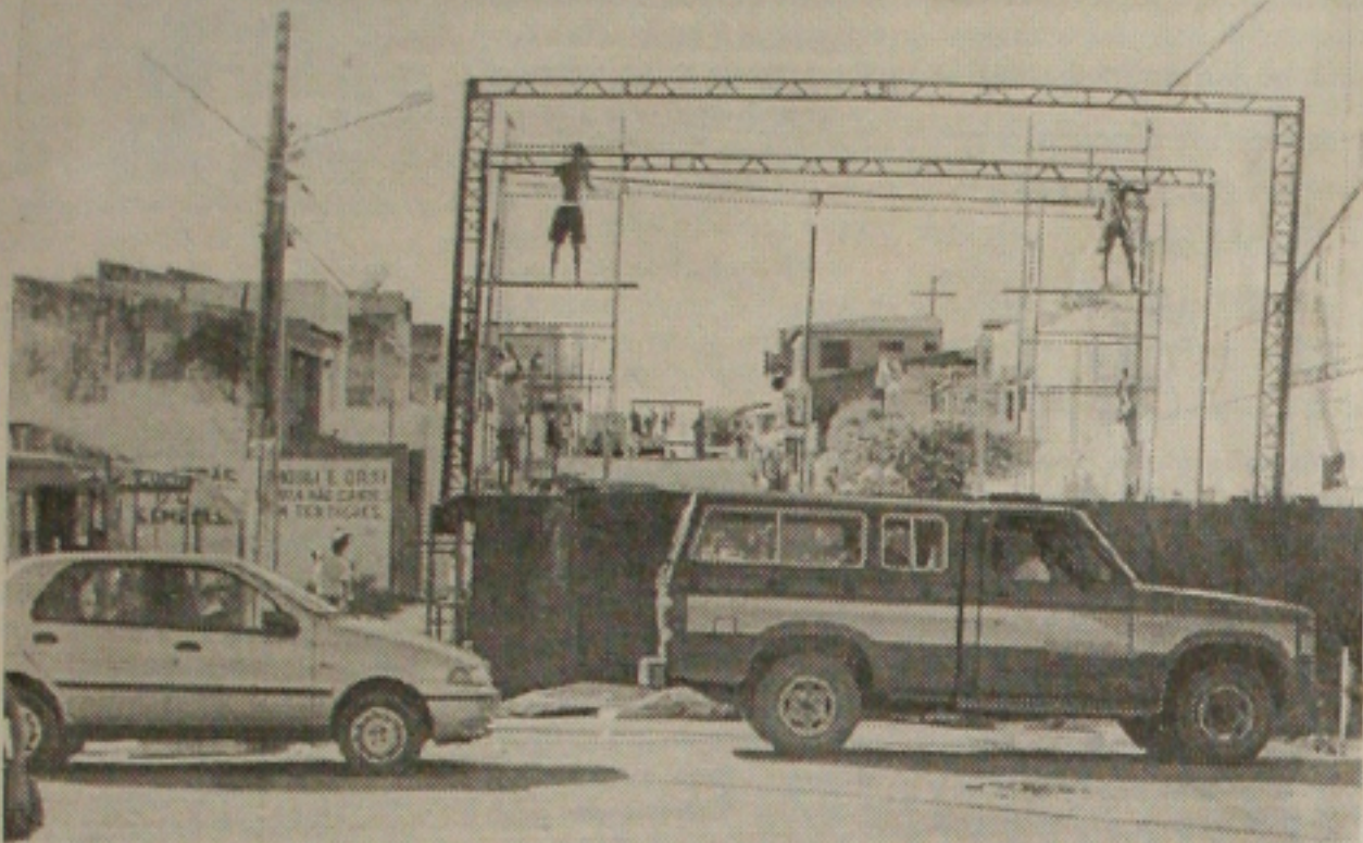
Homens trabalhavam ontem a todo vapor na montagem do palco do Forroço da Rua Siriri, que começa hoje. (Página 2B)
