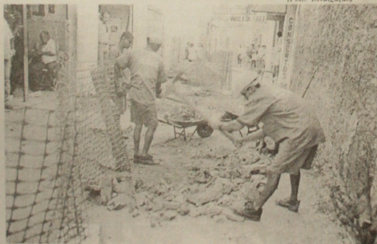
Operários trabalham para a conclusão das obras do centro
