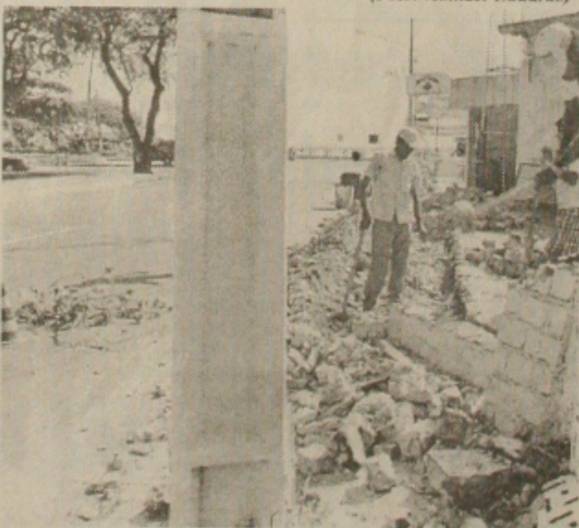
Funcionários da Emurb iniciam recuperação da calçada
