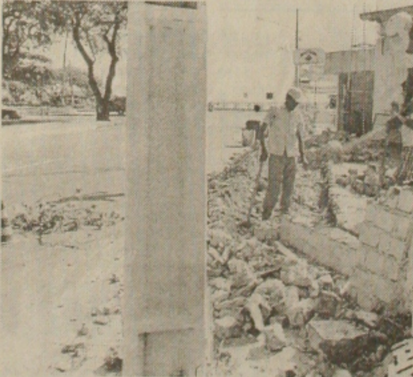
Funcionários da Emurb iniciam recuperação da calçada
