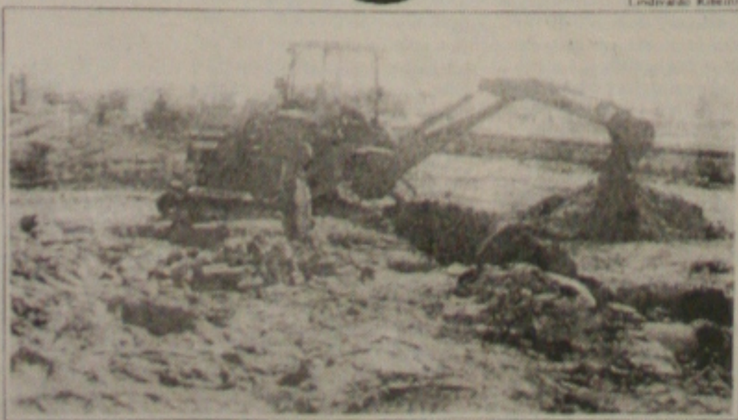
As obras estão em ritmo acelerado
