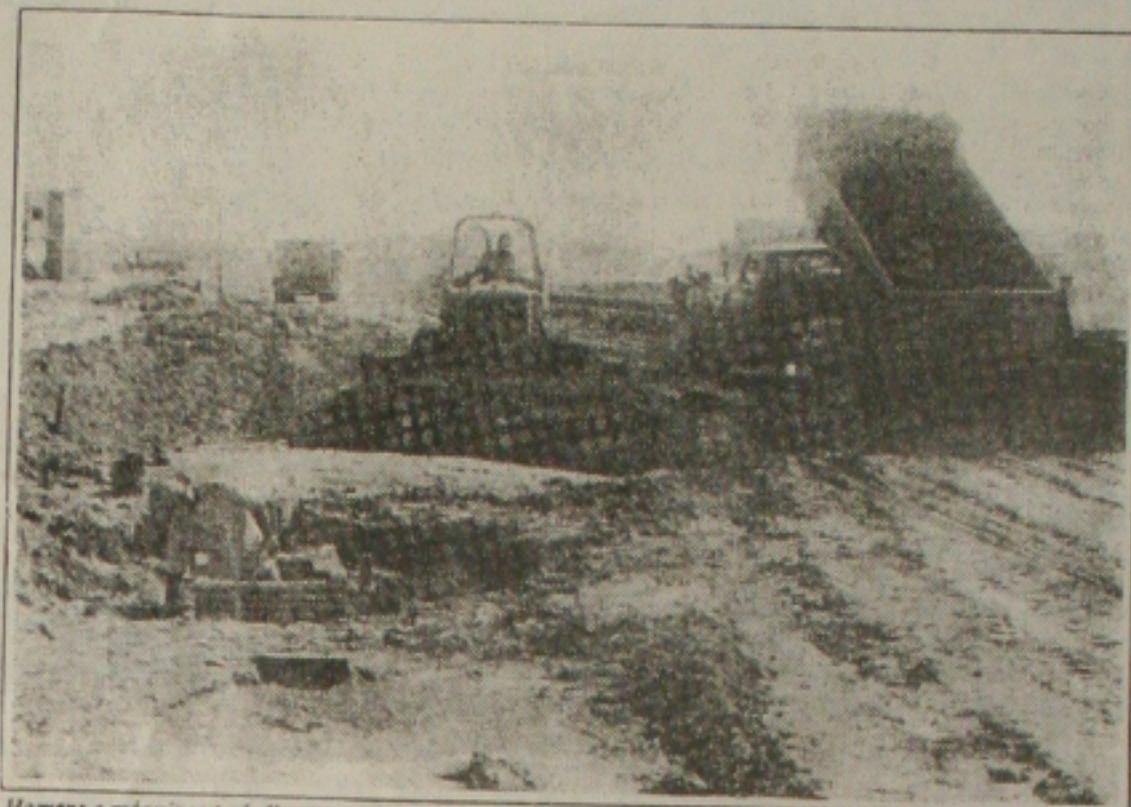
Homens e máquinas trabalhavam a pleno vapor, nos Jardins, onde parte dos terrenos pertence à Norcon
